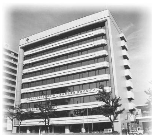
「和歌山県日赤会館」外観
